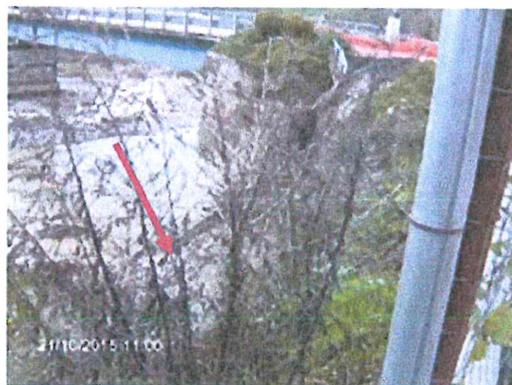
Foto N. 2-3 - Erosione della scogliera e del terrapieno di protezione della base della spalla sx del ponte
