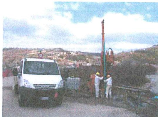
Foto5: L'installazione del tubo cieco da 3", per la successiva prova sismica del tipo "down-hole"
