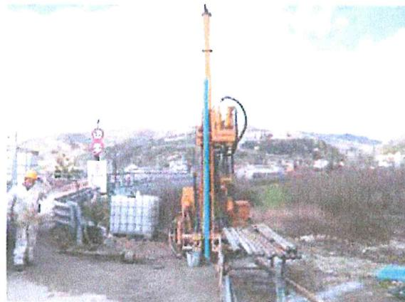
Foto 2: Il foro di sondaggio "S1", realizzato in spalla sx del fiume Ufita, mentre viene attrezzato per la down-hole
