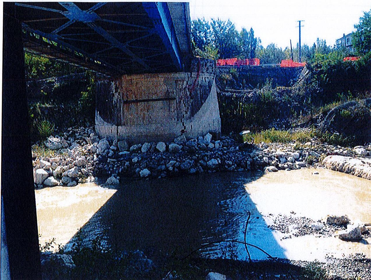
Le deformazioni della spalla sono congruenti con la presenza di un movimento franoso che interessa l'argine a valle, a seguito dello scalzamento al piede del rilevato, fino al coinvolgimento della sede stradale sovrastante.
