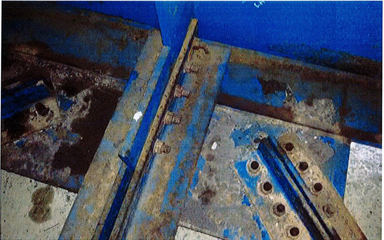
*“Si ribadisce però la necessità di ripristinare il rivestimento superficiale (mediante sabbiatura per rimuovere lo strato di ossido presente e successiva verniciatura per ripristinare lo strato protettivo) sia nelle zone con evidenti screpolature che nelle zone completamente ossidate per evitare l’insorgere di fenomeni irreversibili di tenso-corrosione nel futuro esercizio dell’implacato.*
